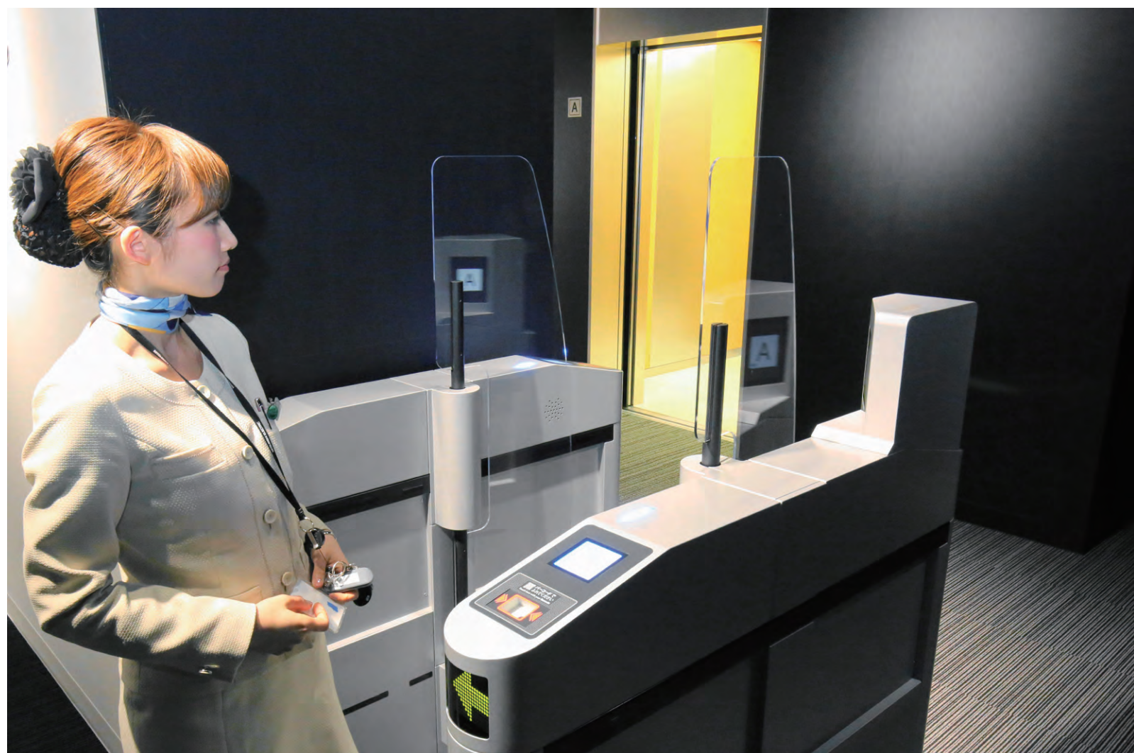
▲エレベーターの機能は急速に進化。入館ゲートと連動したエレベーターも。
