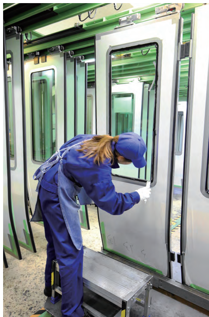
▲乗降用のドアに窓ガラスを取り付けていく。女性が活躍する姿も。
