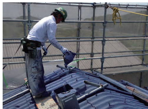
▲衛生陶器の廃棄物は、遮熱塗料用の骨材への応用が検討されている。
