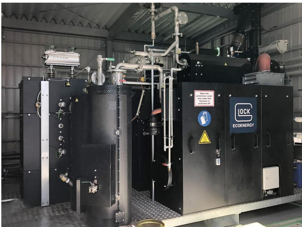
GLOCK ecotech GmbH 社製の木質バイオマスガス化熱電併給設備
