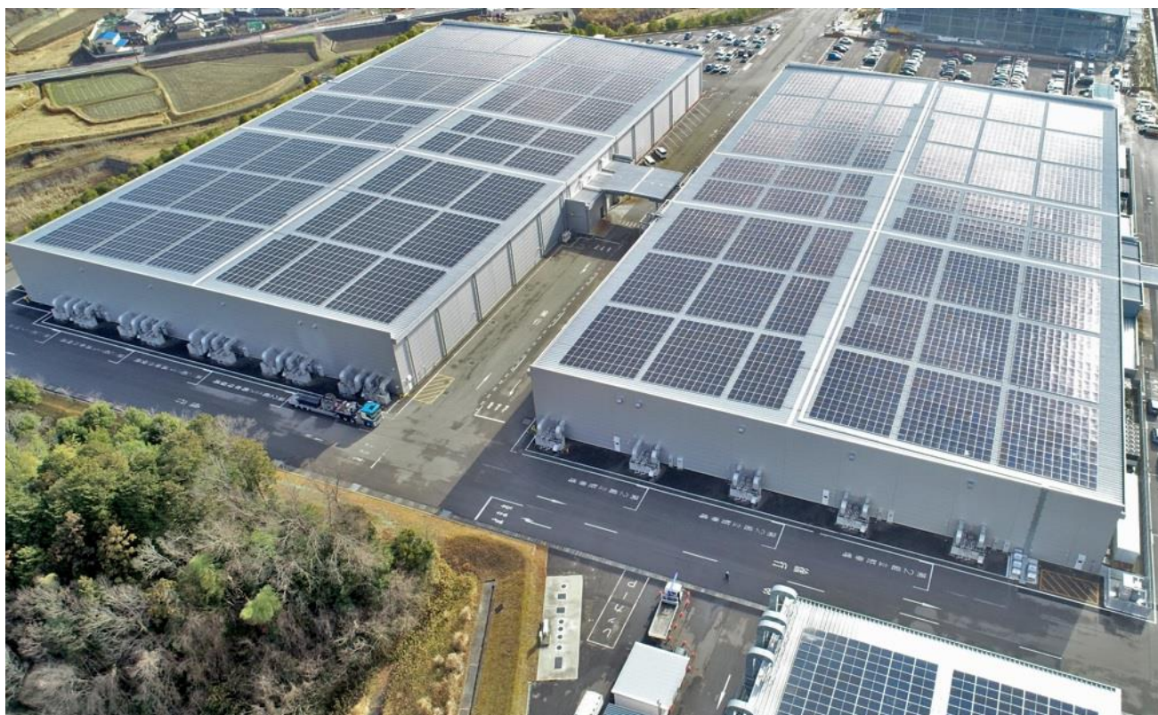
第1期の発電を開始した伊賀事業所の太陽光発電パネル
