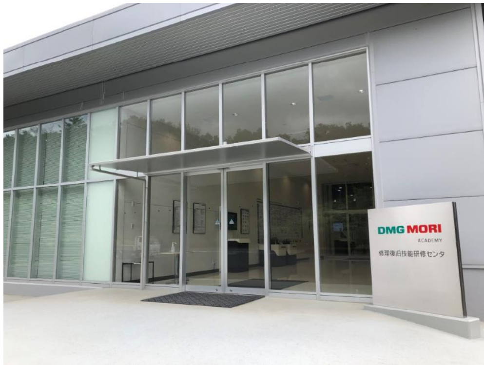
修理復旧技能研修センター 外観
