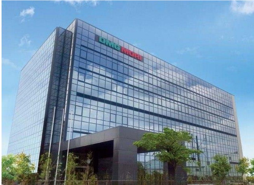
東京グローバルヘッドクォータ外観
