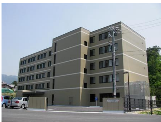
第 2 伊賀寮外観
