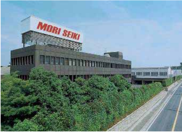
(森精機製作所奈良事業所第二工場外観)
