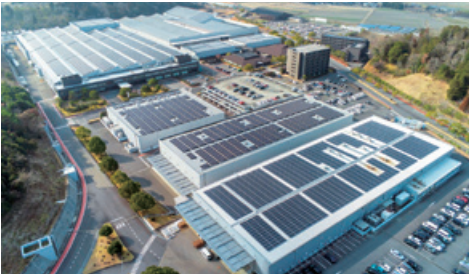
全量発電を開始した伊賀事業所 太陽光発電パネル
