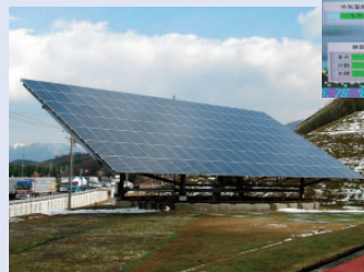
伊賀事業所に設置された太陽光発電設備
