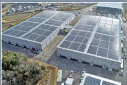
自家消費型太陽光発電システム
