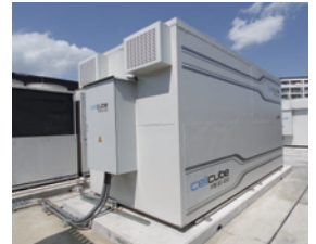
効率的なエネルギー貯蔵 cellcube 大型バッテリーシステムCellCubeは、二酸化炭素の排出量がゼロのエネルギー貯蔵システムです。
