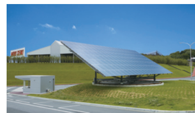
旋回角度220°（東・西に110°）の太陽光パネル
