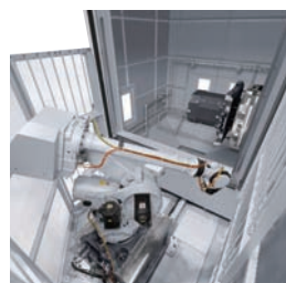
洗浄ステーションとバリ取りロボット
