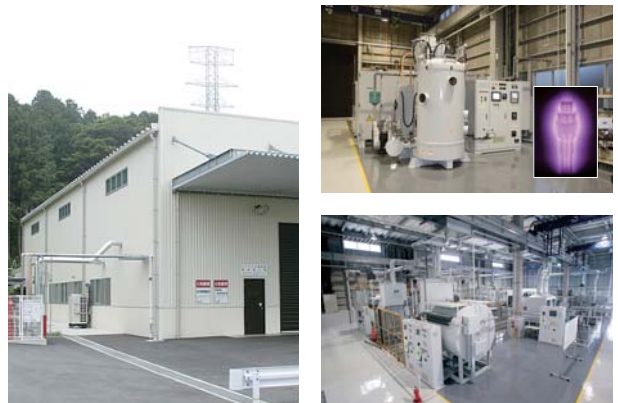
左:熱処理工場外観 右上:イオン窒化装置と内部の様子 右下:浸炭焼入れ炉
