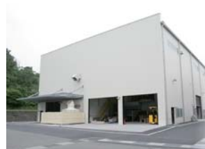
鋳物工場外観
